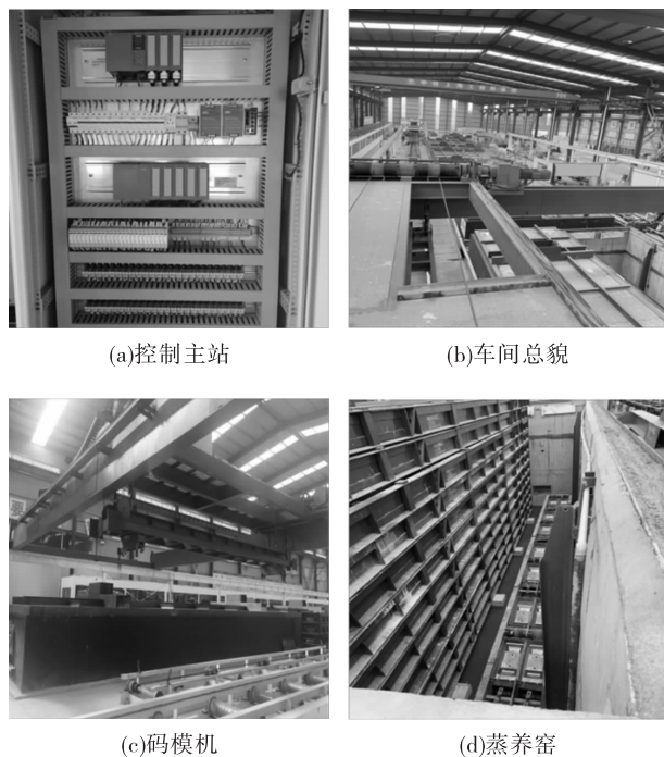
图7 现场安装使用情况
