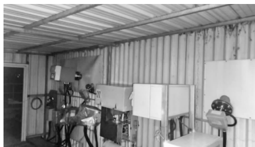
图 9 碳排放监测系统现场安装实物
